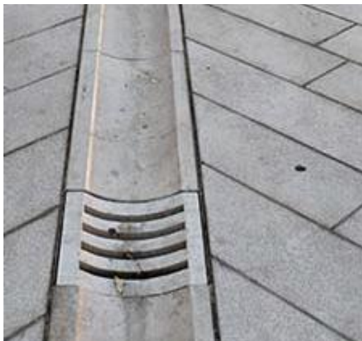
1 - kanalica za linearnu odvodnju unutar oploćenja; 2 - kamena rešetka za odvodnju ukomponirana u oploćenje; 3 - kontrolno okno u oploćenju; 4 - slivne rešetke jednakog materijala i modula kao betonske ploče; 5,9 - linearna metalna rešetka u oploćenju; 6 - tanka kanalica u kamenom oploćenju trga u St-Flouru (Francuska), In Situ LA; 7 - metalna kanalica s tradicionalnim uzorkom; 8 - linearna odvodnja na trgu u povijesnoj jezgri Coimbra (Portugal), BB Arquitectos; 10 - kanal za odvodnju u kamenom oploćenju; 11 - slivnik kao dio oploćenja
