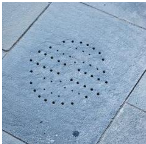
1 - kanalica za linearnu odvodnju unutar oploćenja; 2 - kamena rešetka za odvodnju ukomponirana u oploćenje; 3 - kontrolno okno u oploćenju; 4 - slivne rešetke jednakog materijala i modula kao betonske ploče; 5,9 - linearna metalna rešetka u oploćenju; 6 - tanka kanalica u kamenom oploćenju trga u St-Flouru (Francuska), In Situ LA; 7 - metalna kanalica s tradicionalnim uzorkom; 8 - linearna odvodnja na trgu u povijesnoj jezgri Coimbra (Portugal), BB Arquitectos; 10 - kanal za odvodnju u kamenom oploćenju; 11 - slivnik kao dio oploćenja
