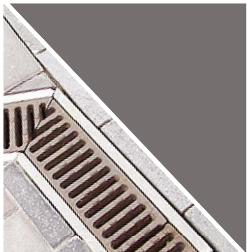
1 - kanalica za linearnu odvodnju unutar oploćenja; 2 - kamena rešetka za odvodnju ukomponirana u oploćenje; 3 - kontrolno okno u oploćenju; 4 - slivne rešetke jednakog materijala i modula kao betonske ploče; 5,9 - linearna metalna rešetka u oploćenju; 6 - tanka kanalica u kamenom oploćenju trga u St-Flouru (Francuska), In Situ LA; 7 - metalna kanalica s tradicionalnim uzorkom; 8 - linearna odvodnja na trgu u povijesnoj jezgri Coimbra (Portugal), BB Arquitectos; 10 - kanal za odvodnju u kamenom oploćenju; 11 - slivnik kao dio oploćenja
